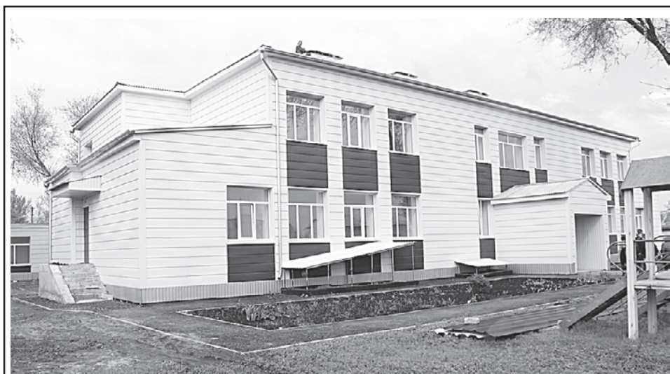
Детский сад «Аленка» в Новосветловке. Восстановительные работы после разрушения украинцами - на финишной прямой.
