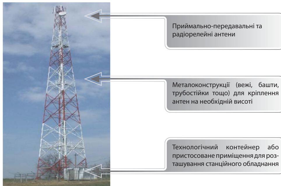
Мал.2 Загальний вигляд типової базової станції
